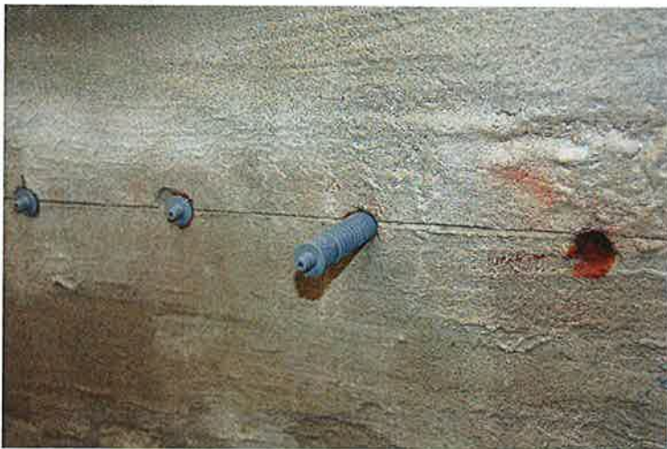
Bild B2: Einsetzen der Packer
