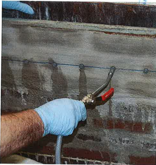
Bild B3: Durchführung der Druckinjektion
