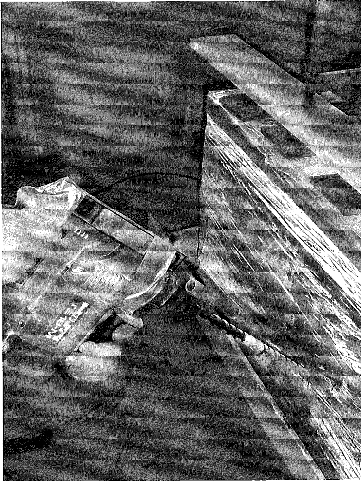
Bild 1 Anlegen der Bohrkanäle in das Mauerwerk mit DFG 80 %
