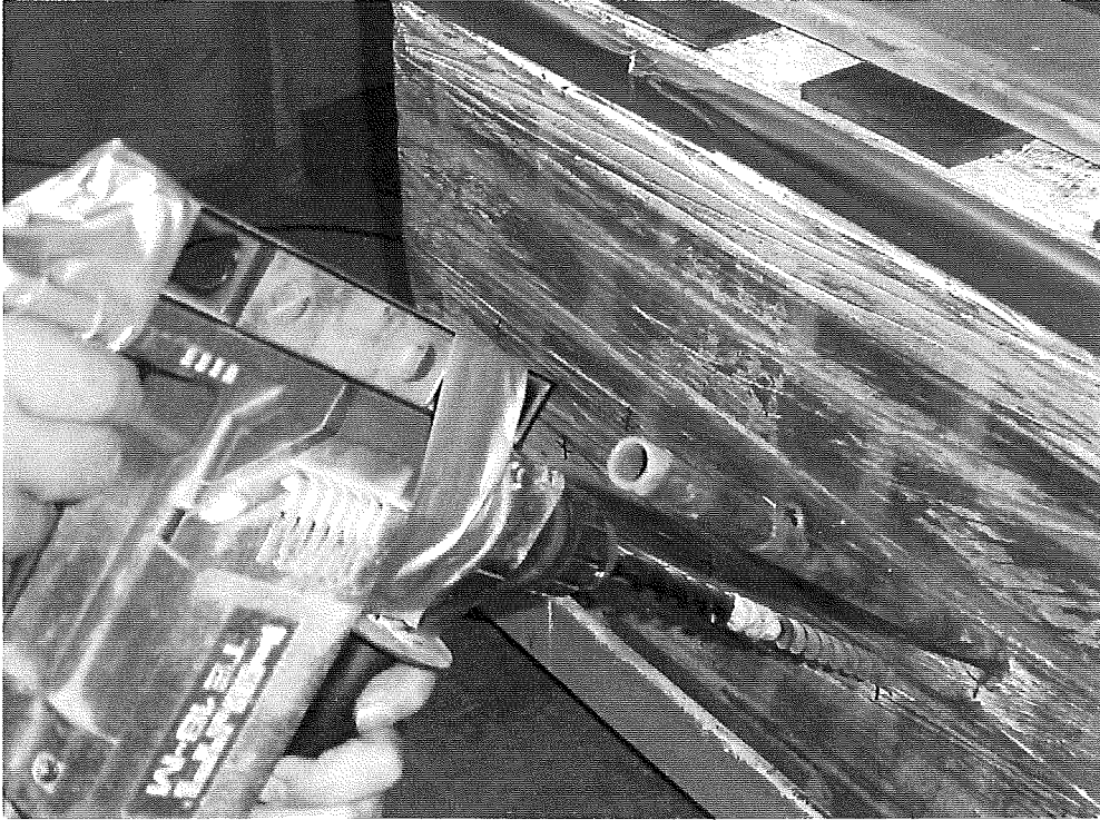
Bild 1: Anlegen der Bohrkanäle
