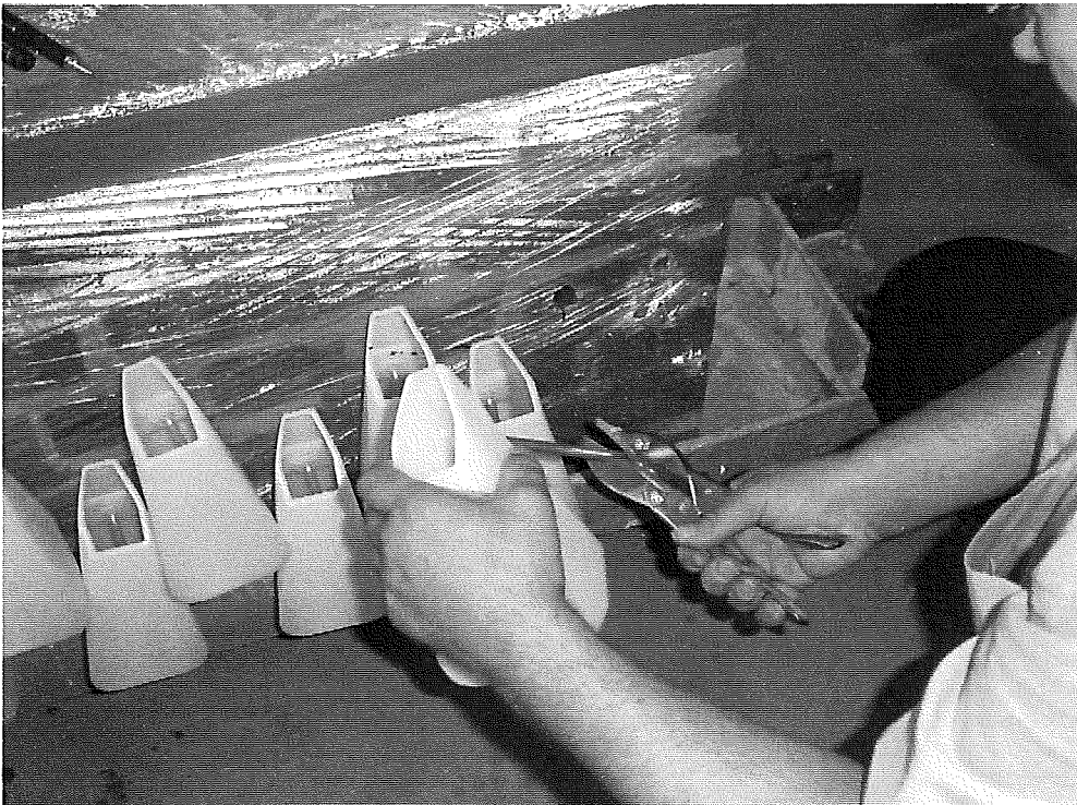
Bild 2: Anpassen der Kunststoffröhrchen an die Bohrlochlänge
