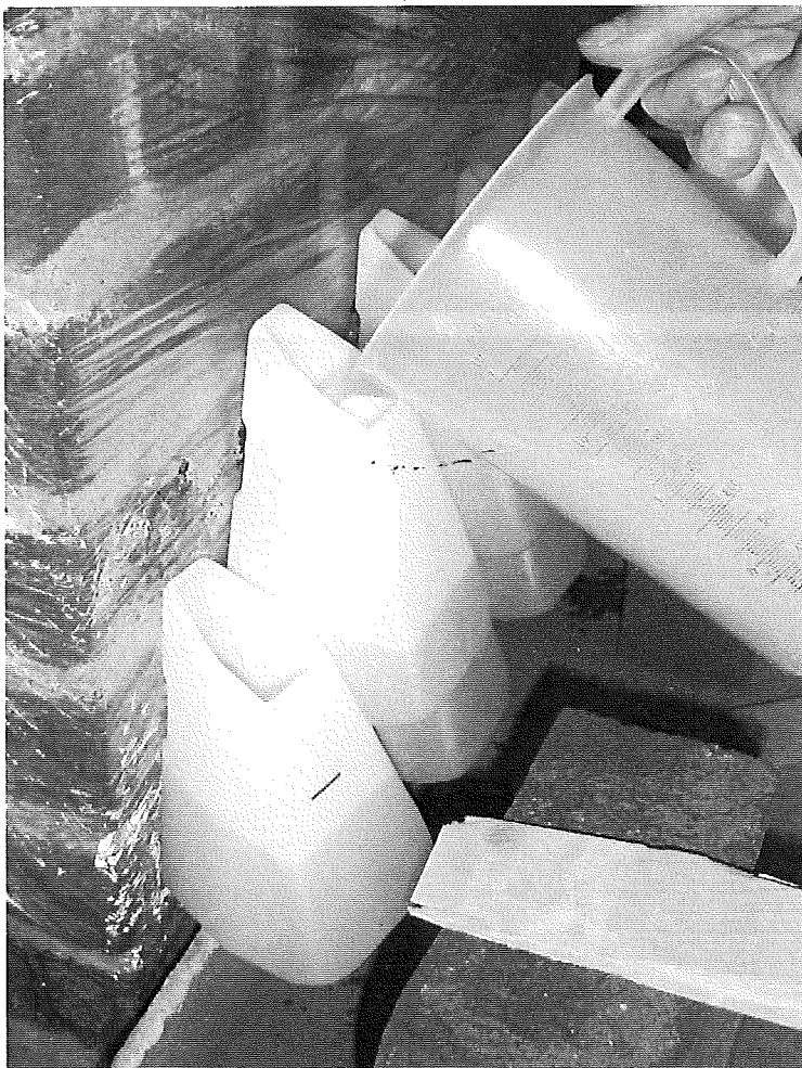
Bild 4: Befüllung der Vorratsbehälter mit INTRASIT Verkieselung
